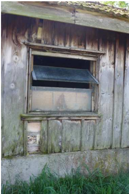
Stallfenster an der nördlichen Stallwand (2023)
