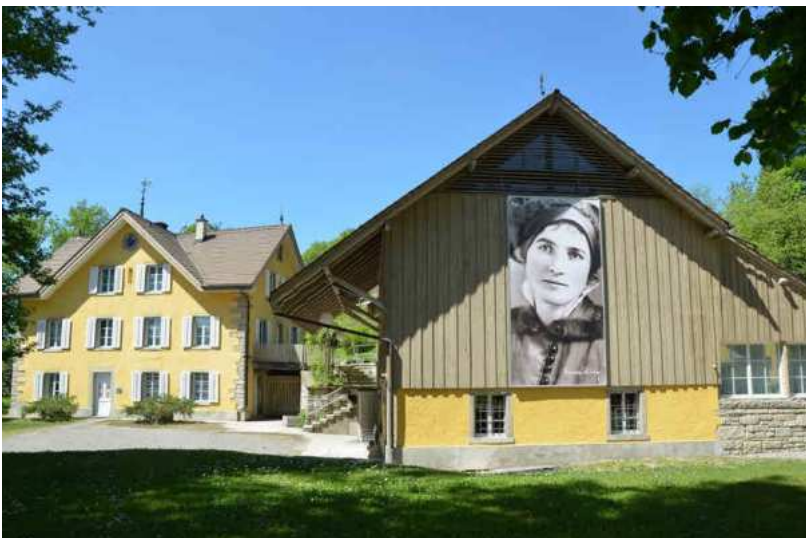
Ansicht der Baugruppe von Südosten (2019)
