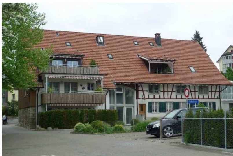
Südwestansicht nach dem Umbau von 2010 (2019)
