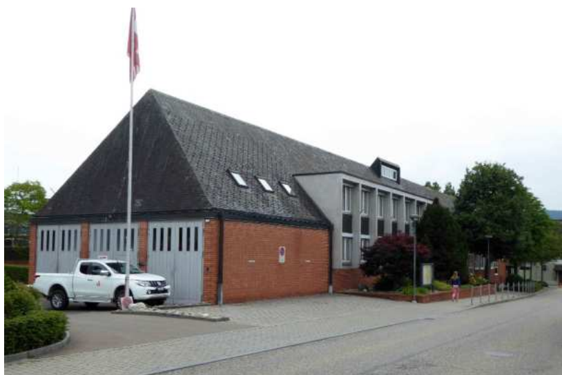
Ansicht Gemeindehaus von Norden (2019)
