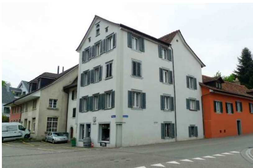
Ansicht Gebäudekomplex von Westen (2019)
